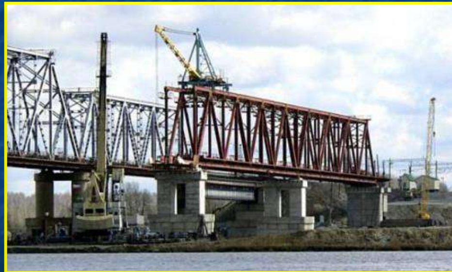
Строительство автомобильного моста через р.Кама
